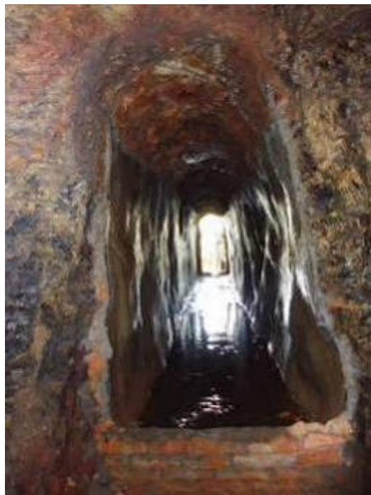
Fig. 6 I primi 10 metri ricoperti di cemento visti dall'interno verso l'ingresso della galleria
