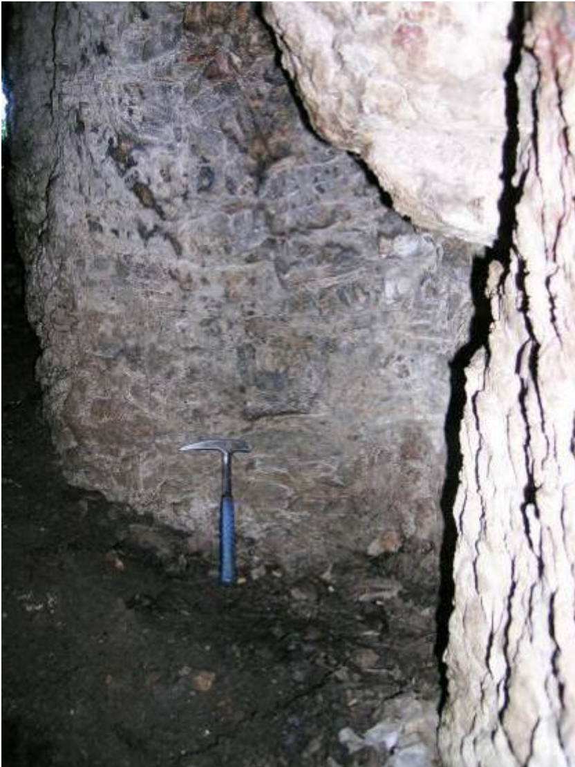
Fig. 13 Slargo realizzato, verosimilmente, per consentire il transito di due minatori che procedevano in senso inverso.
