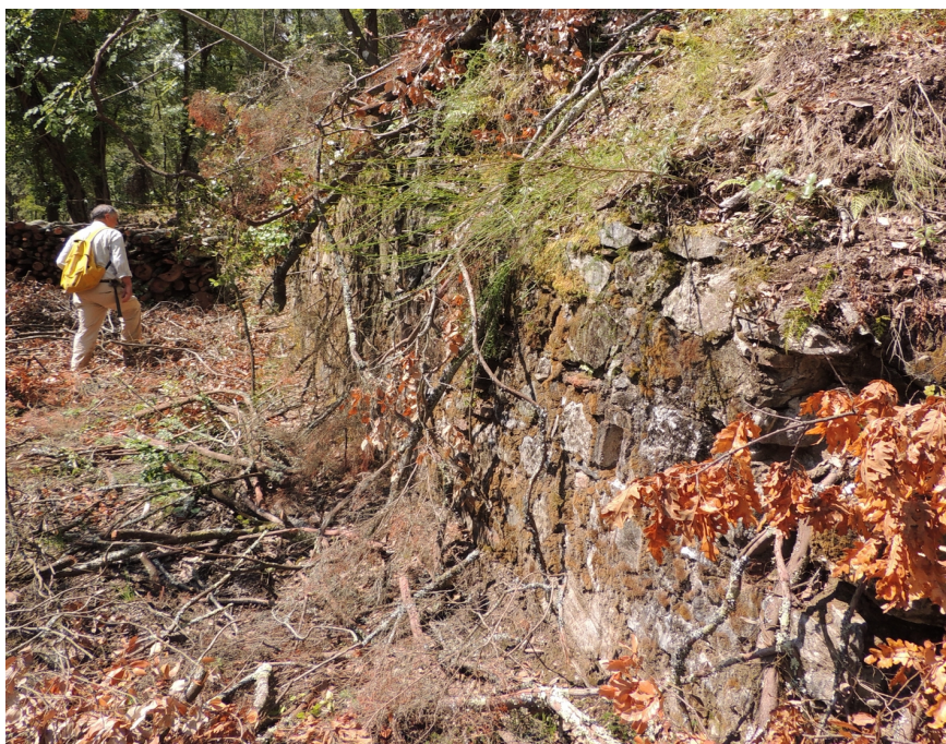
Fig. 14 Muro a retta a protezione del Piano della laveria
