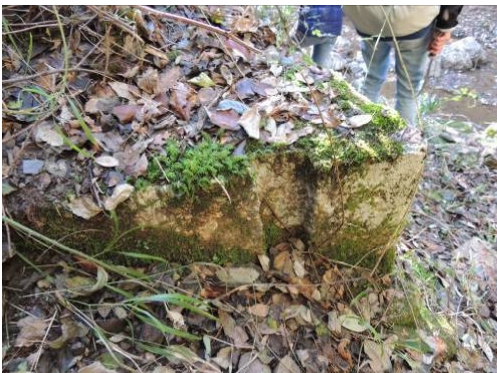
Fig. 4 Solco di alloggiamento di una chiusa per impedire che le acque del torrente entrassero all'interno delle gallerie
