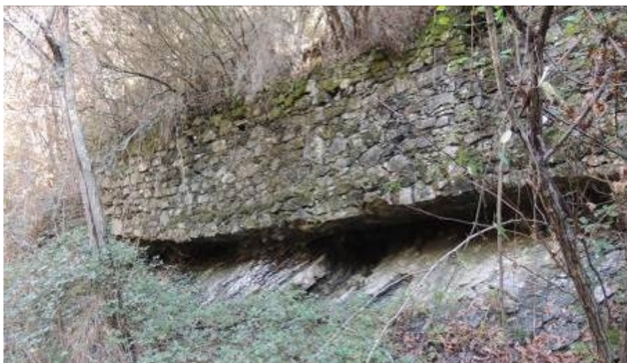
Fig. 10 L'azione erosiva del torrente ha asportato parte degli strati rocciosi che sorreggevano la base di appoggio della galleria.
