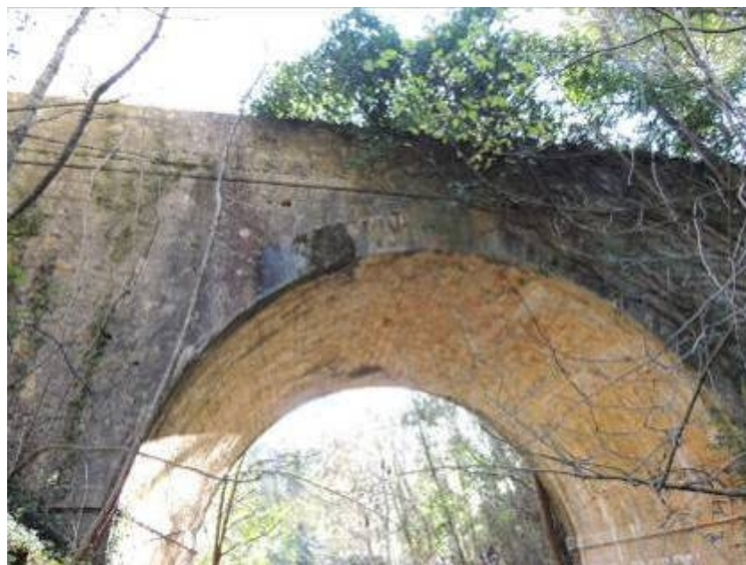
Fig. 12 Bel ponte a tutto sesto per l'attraversamento della ferrovia decauville verso la frantumazione.
