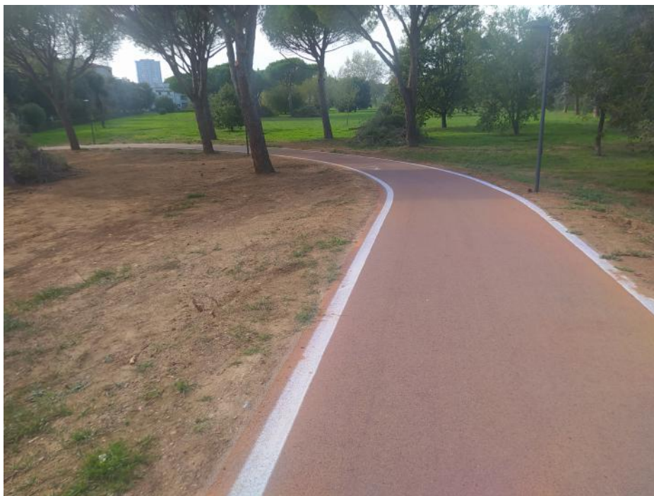
Asfalto con inerte trasparente
