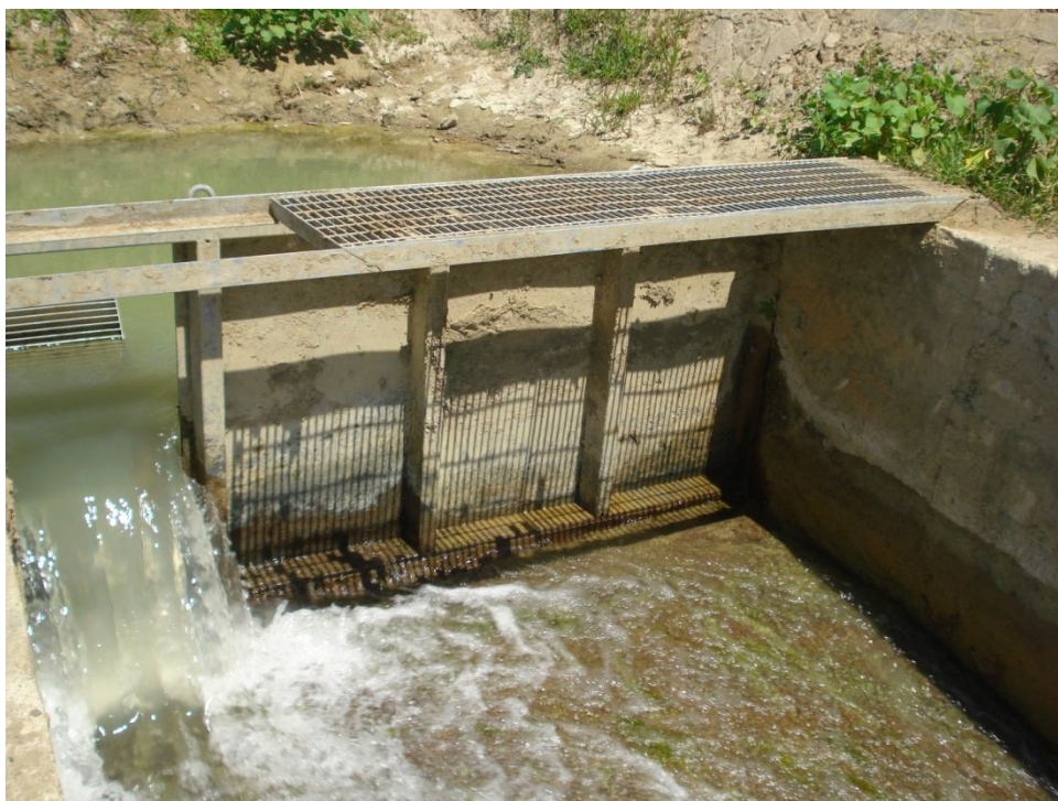
Figura 26 - Opera di risalita per i pesci al momento della realizzazione.
