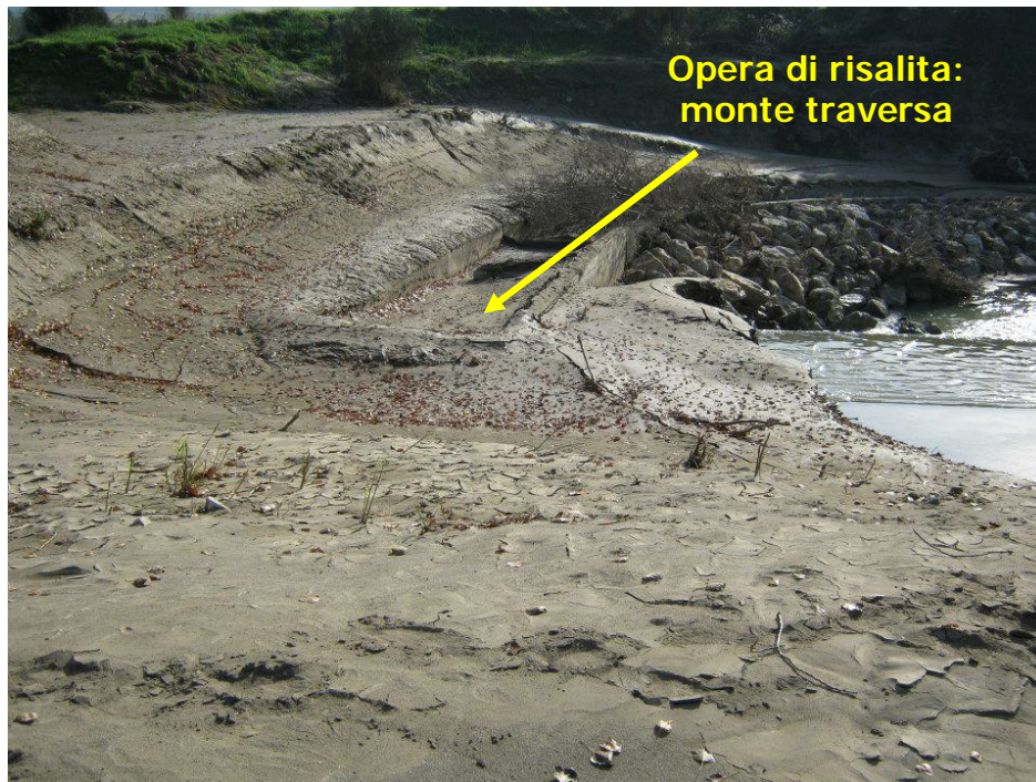
Figura 25 – Dettagli della traversa: opera di risalita per i pesci.
