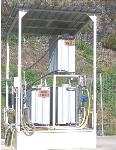
Figura 1: Esempio di skid per i serbatoi dell'olio e del glicole
