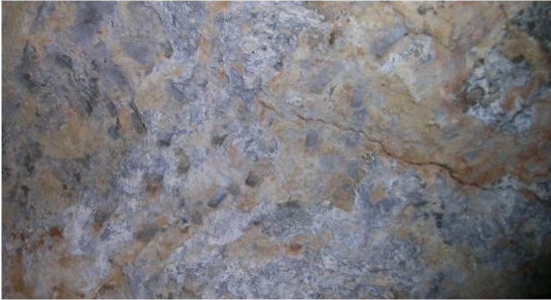
Fig. 17. Ben visibili i segni lasciati da un utensile a penna di larghezza di circa 2 cm.
