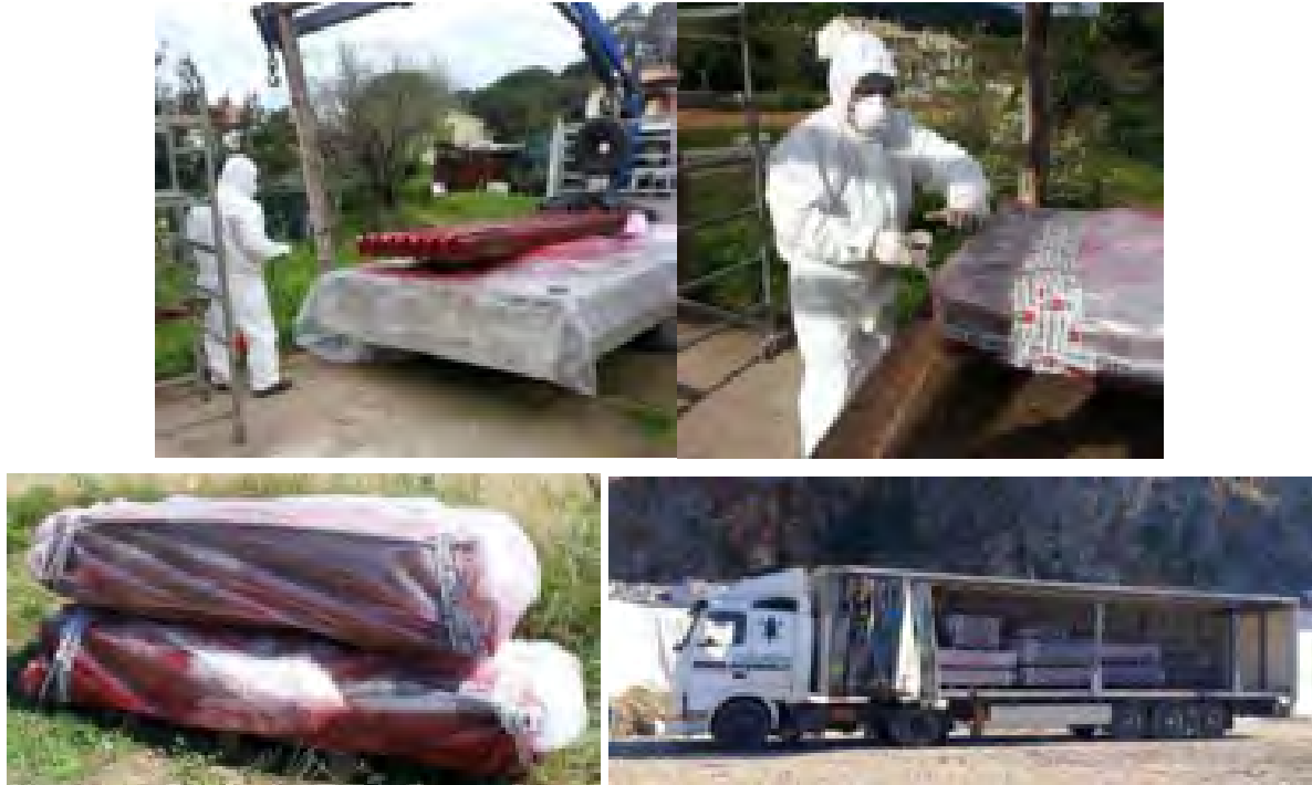
Figura 18 – Trattamento e confezionamento lastre in MCA
