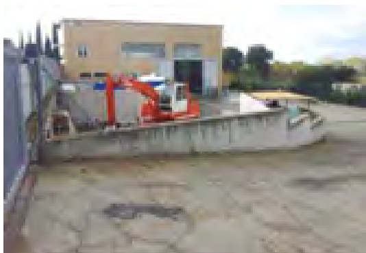
Figura 10 – Dettaglio rampa di accesso piazzale inferiore
