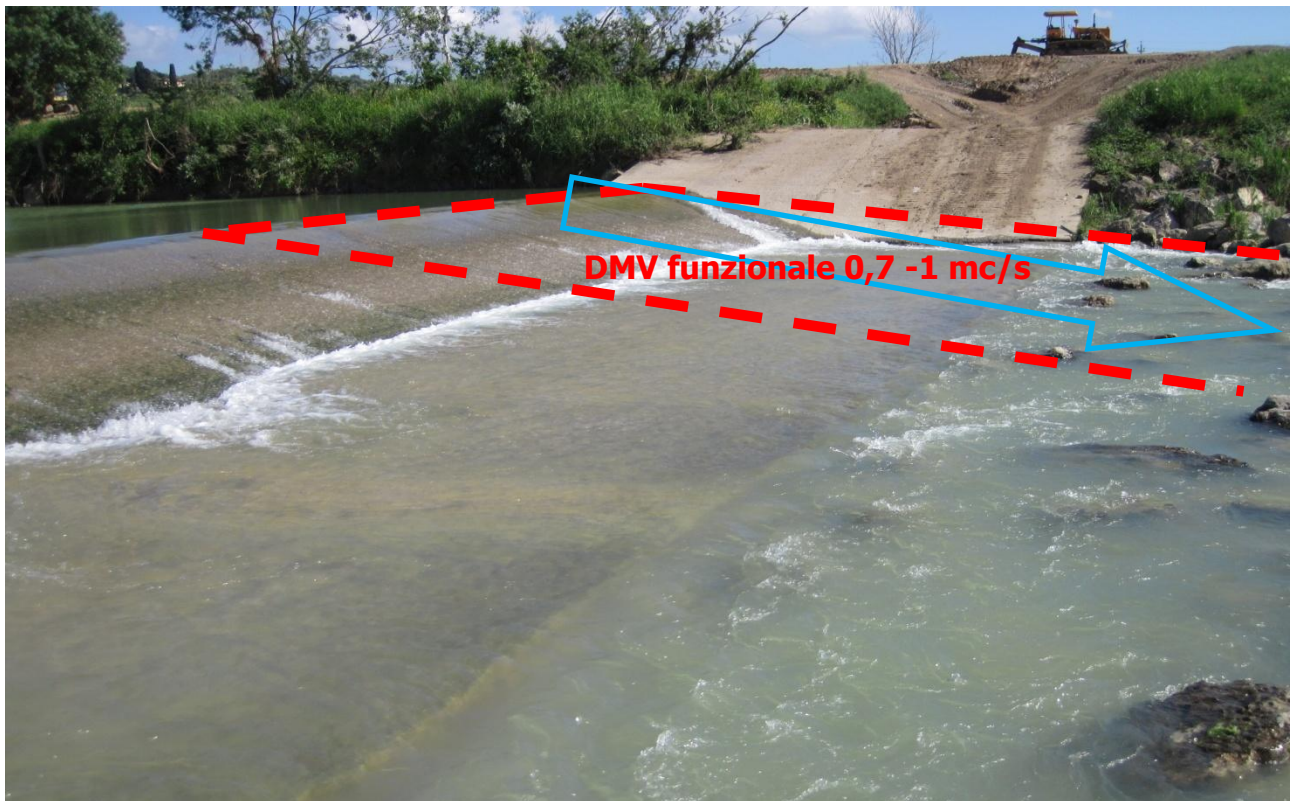
Figura 33 – Porzione di traversa da adeguare per il rilascio del DMV funzionale.
