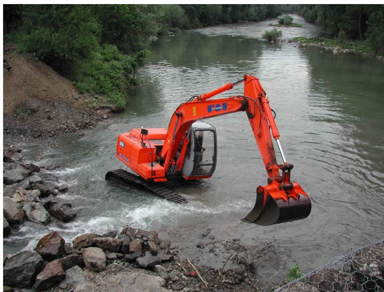
Figura 34 - Esecuzione dei lavori in alveo non corretta.
