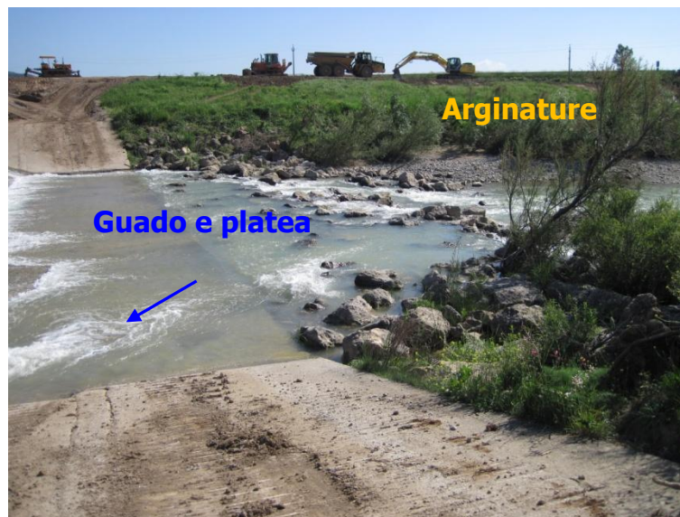
Figura 26 – Dettagli della traversa: guado in cls, platea in scogliera, arginature in terra battuta.
