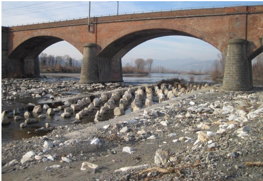
Figura 12: Esempio di scala di risalita a fish ramp
