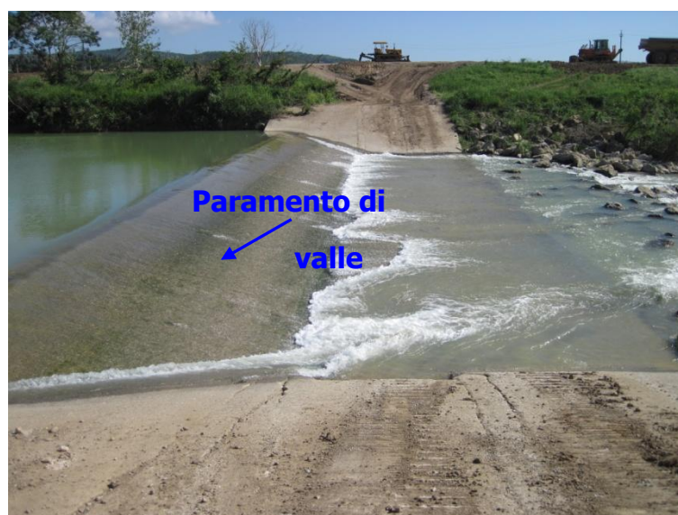
Figura 27 – Dettagli della traversa: paramento di valle in cls.
